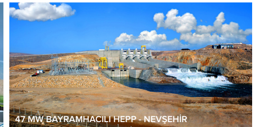
47 MW BAYRAMHACILI HEPP - NEVŞEHİR
